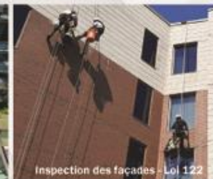
Inspection des façades - Loi 122
