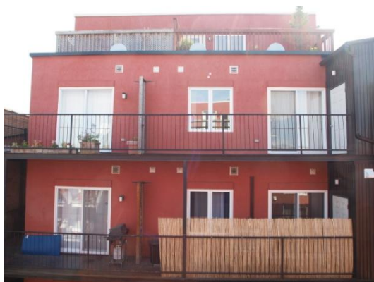
Fig. 1 Exemple de bâtiment recouvert de ciment-acrylique
