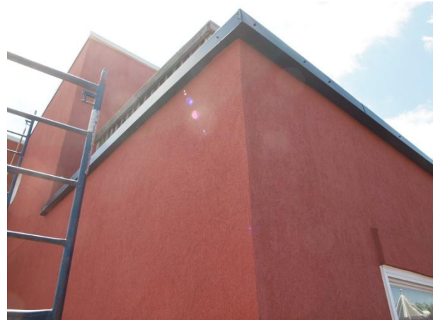
Fig. 11 Pose de l'enduit de ciment-acrylique
