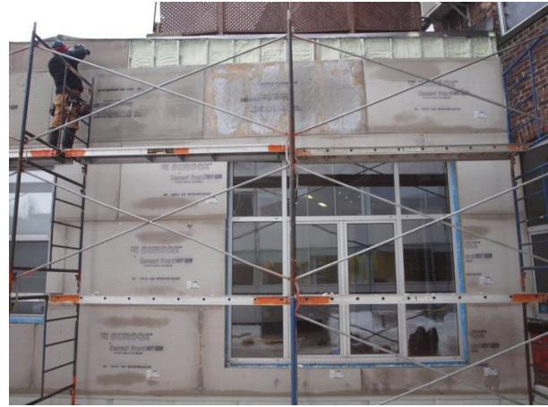
Fig.10 Mise en place des panneaux de ciment-léger
