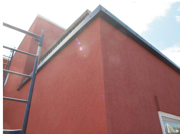
Fig. 11 Pose de l'enduit de ciment-acrylique
