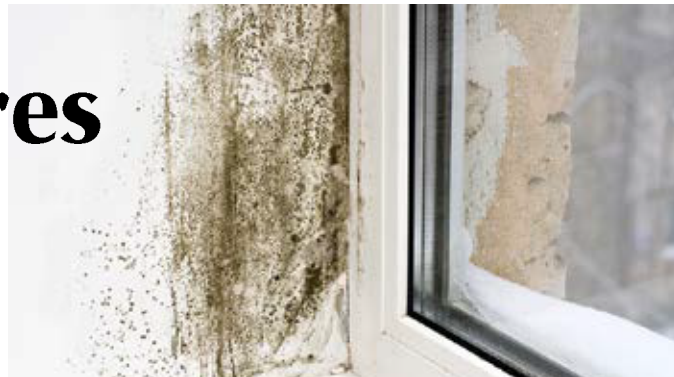
Moisissures sur placoplâtre
