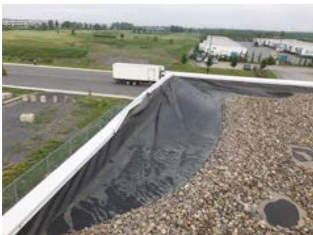
Toiture mal fixée arrachée par le vent.
