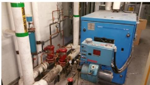
Photo 3 : Chaudière de chauffage au gaz naturel
