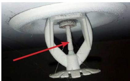
Photo 2 : Ampoule de déclenchement de gicleur montrant des traces de peinture
