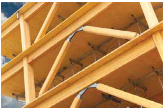
Figure 15. Exemple de structure de bâtiment en bois lamellé croisé (CLT) . The University of British Columbia Earth Sciences Building . Architects: Perkins+Will Canada Architects Co. Photo prise par K. K. Law.
